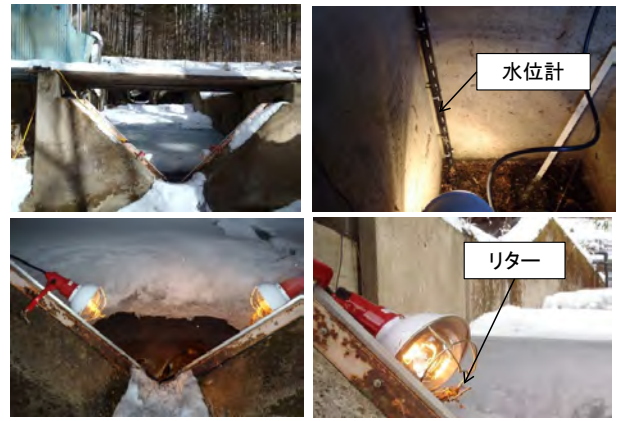
図6 冬季の量水堰の様子
