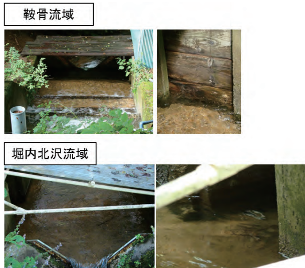
図4 9月6日に撮影した量水堰と水位観測点入口の落とし板の様子 上段が鞍骨流域、下段が堀内北沢流域の写真であり、それぞれ、左が満砂した堰の様子、右が水位観測点入口の落とし板の様子を示している。両流域とも堰が満砂しているが、鞍骨流域の堰では土砂の堆積により、落とし板の下を通水部分が閉塞していた。堀内北沢流域の堰では落とし板が外れていた。
